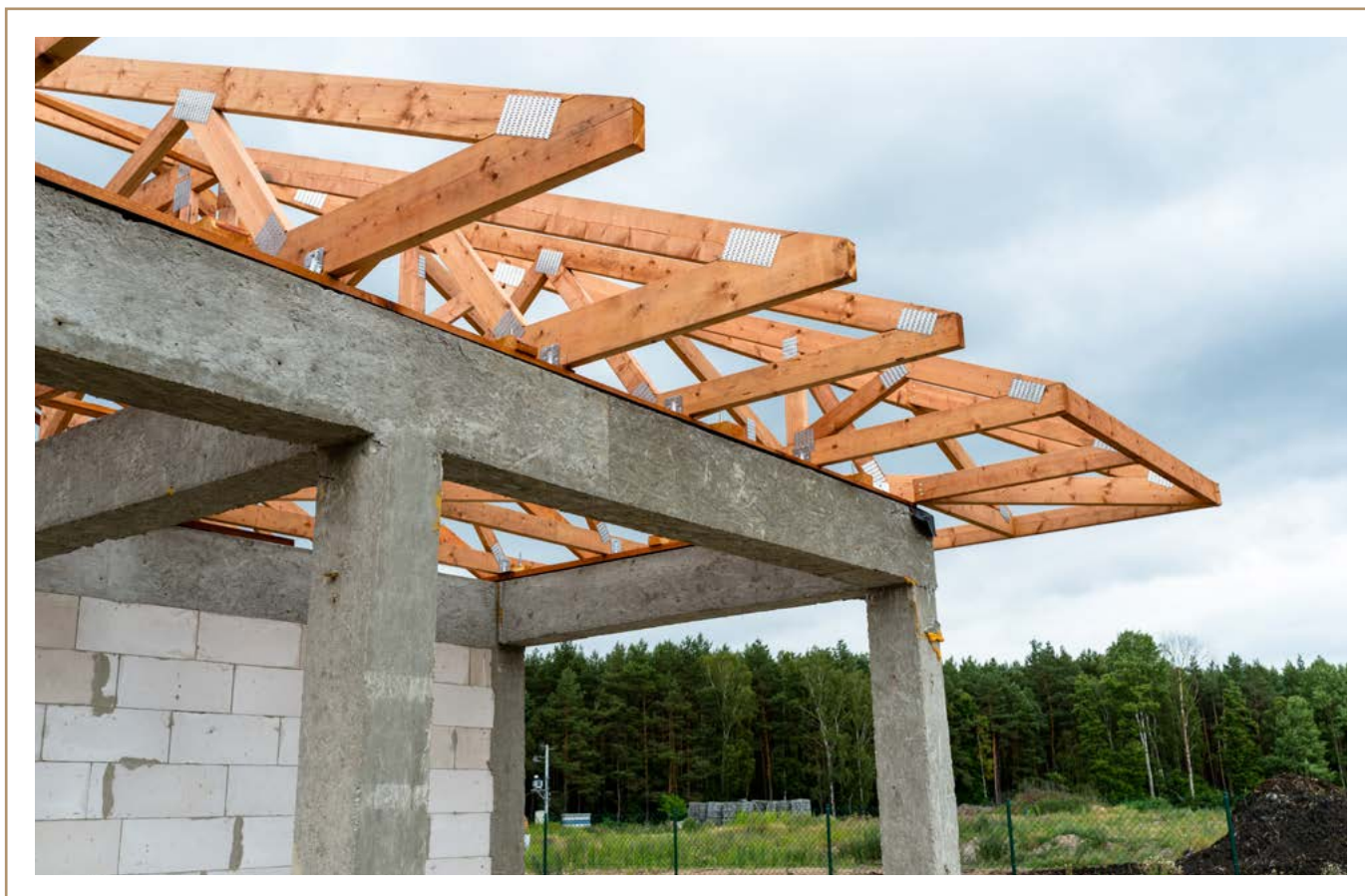
18. ábra. Rácsos tartós fedélszerkezet
