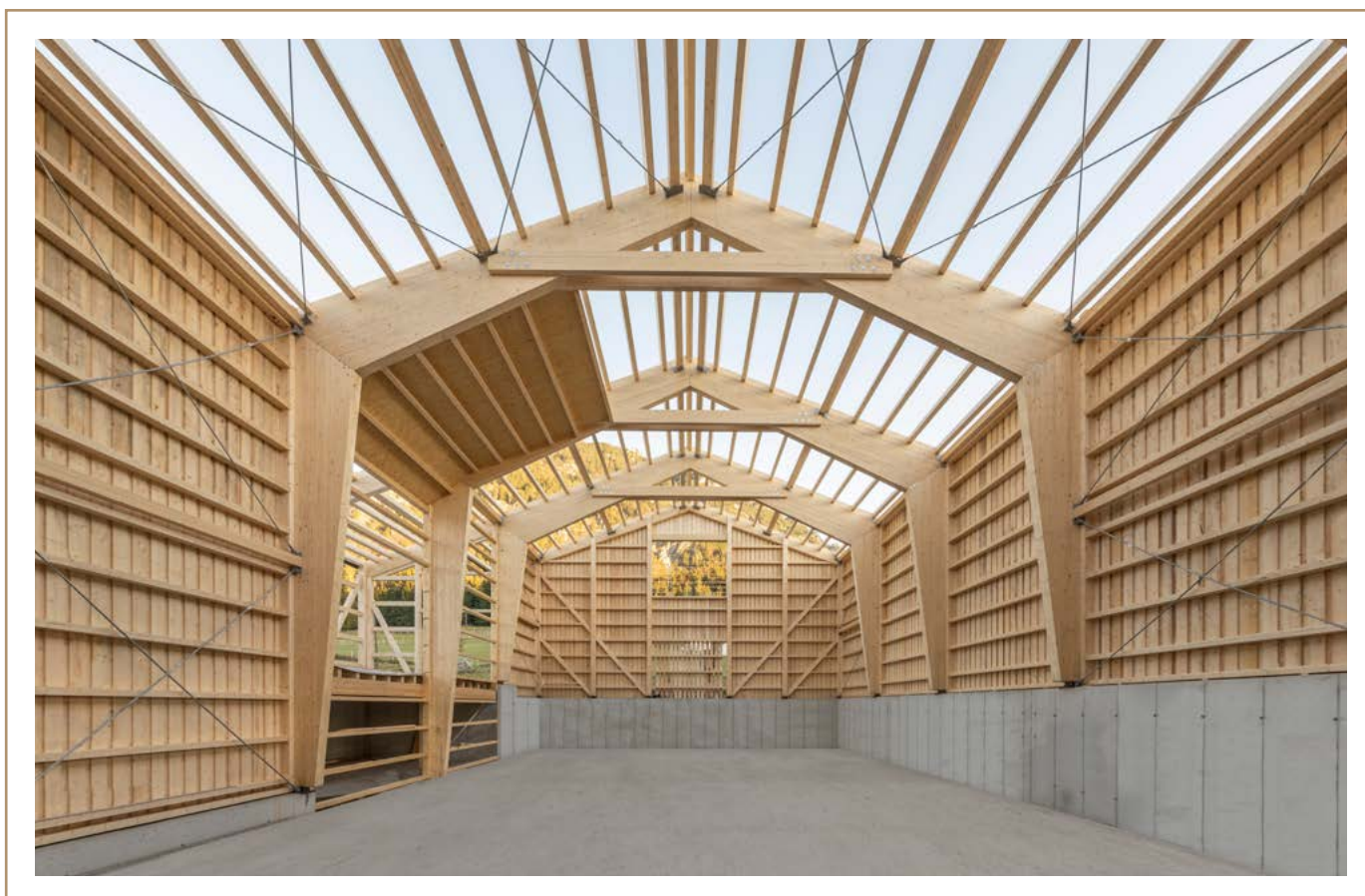
19. ábra. Rétegelt ragasztott fa fedélszerkezet
