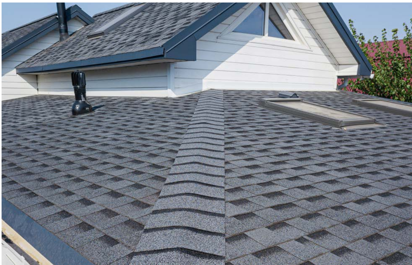
22. ábra. Bitumenes zszindely fedés
