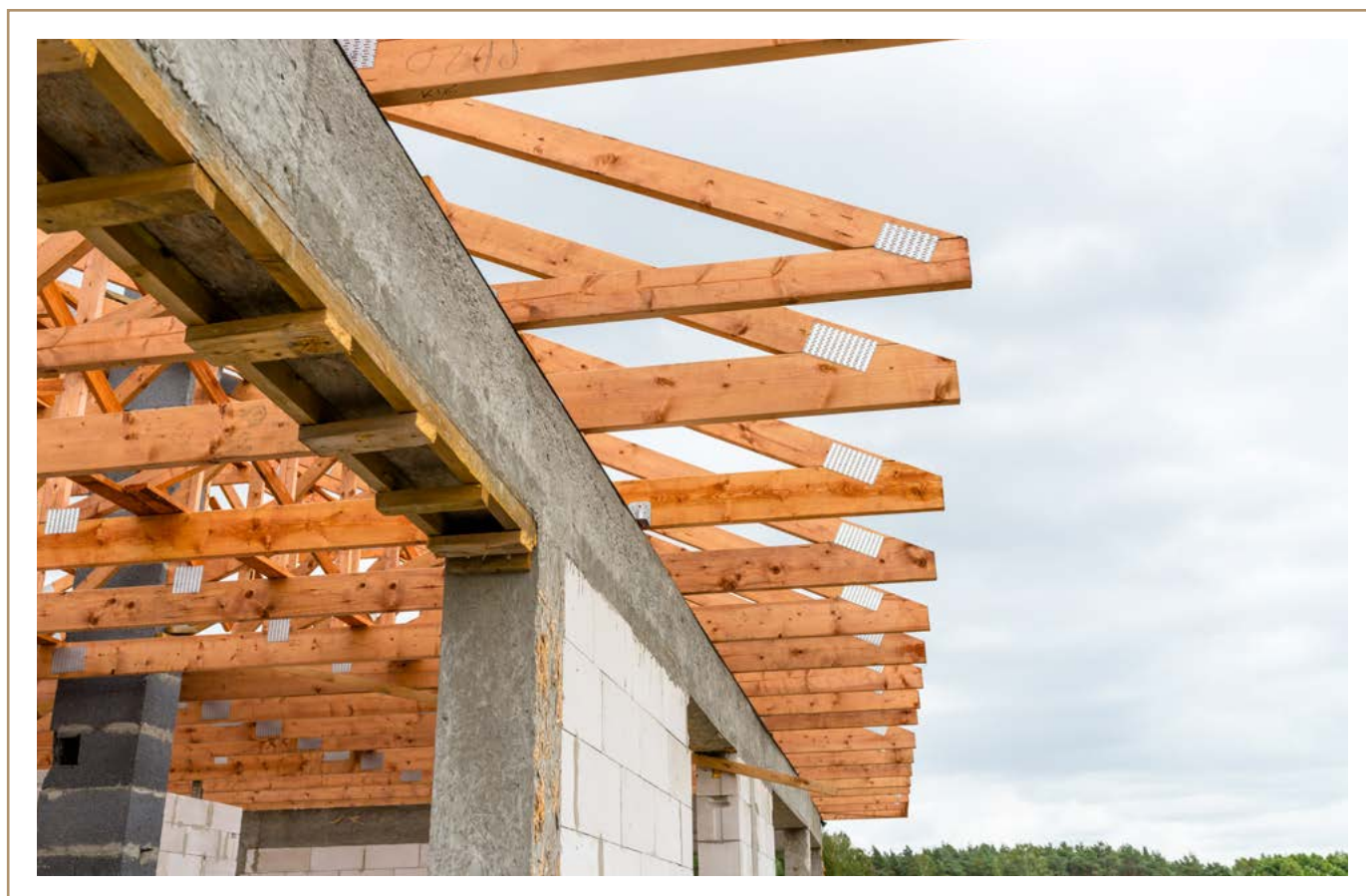
17. ábra. Rácsos tartós fedélszerkezet
