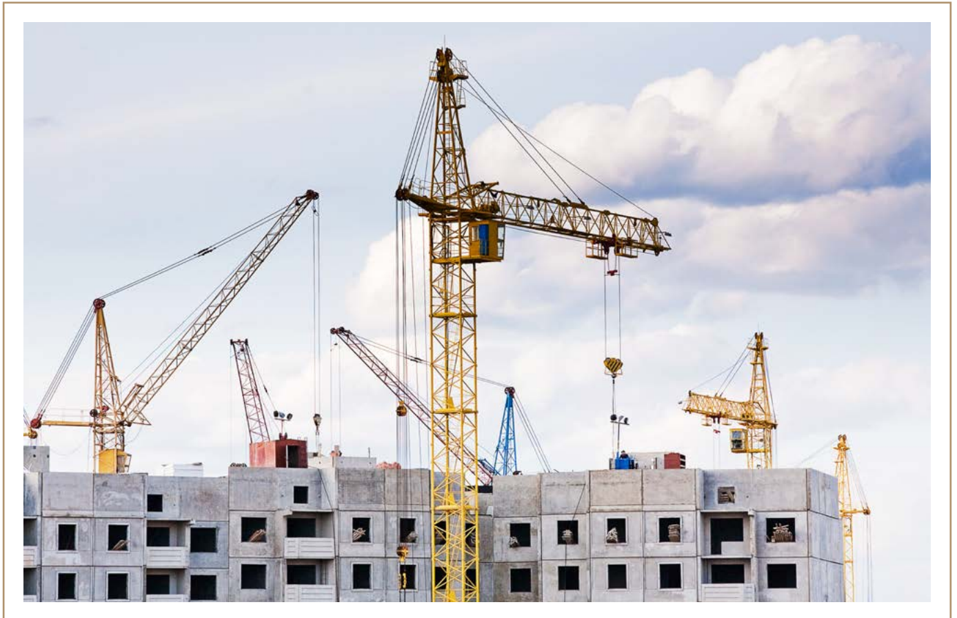
36. ábra. Paneles építési mód
