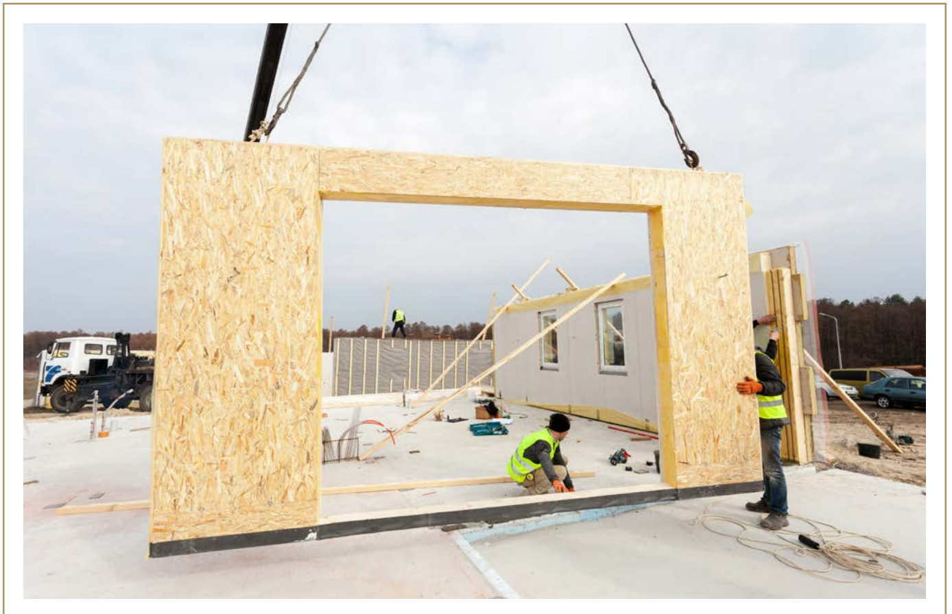
37. ábra. Előregyártott falpanelek összeállítása
